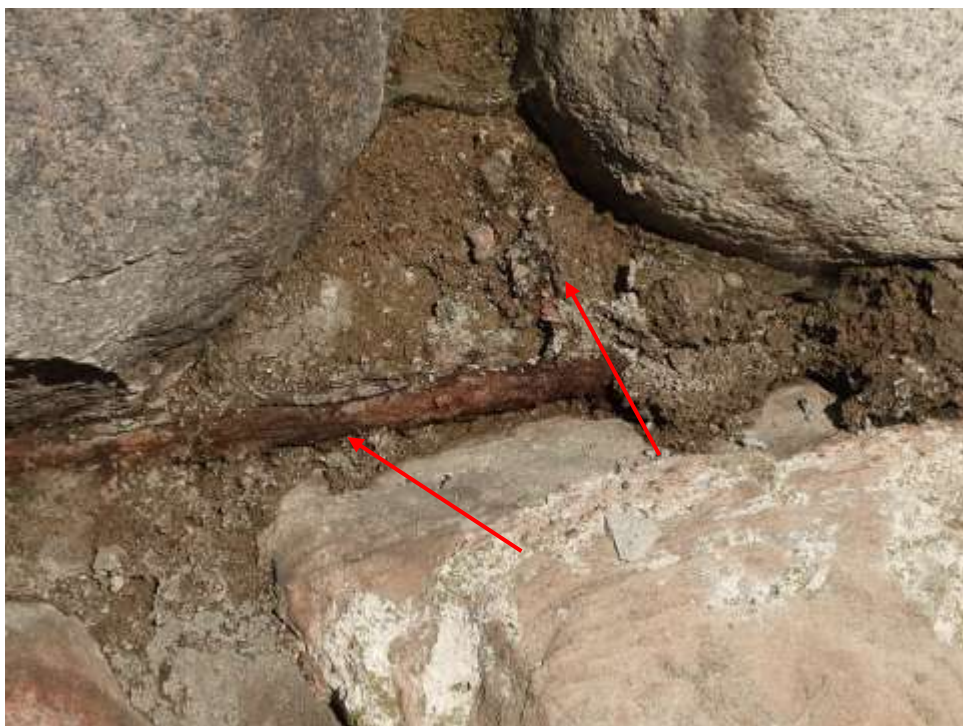
25 nuotrauka. Suiręs ir išplautas siūlių skiedinys, matosi plika surūdijusi rišančioji armatūra
