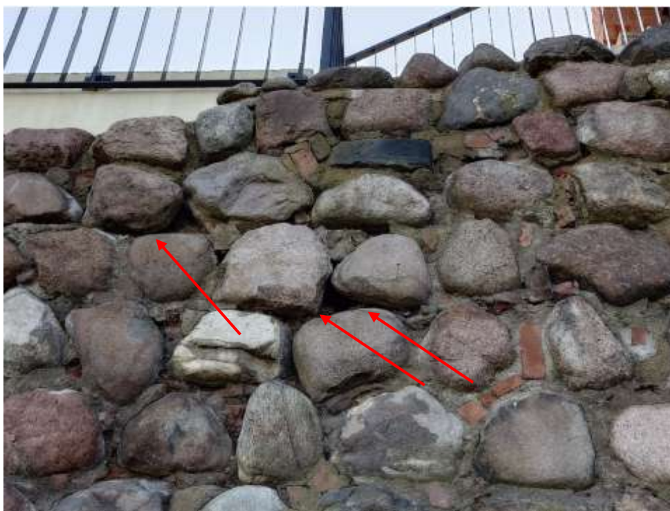
3 nuotrauka. Suiręs ir išplautas akmens-plytų mūro siūlių skiedinys, kai kurie kamienys netekę matomos atramos
