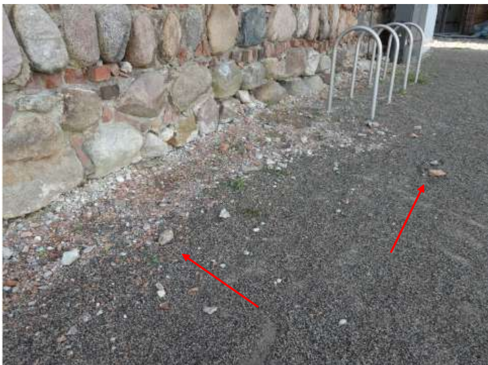
33 nuotrauka. Ant praėjimo į pilį tako gulintys ištrupėję skiedinio ir keraminių plytų gabaliukai, kai kurie jų stambesni
