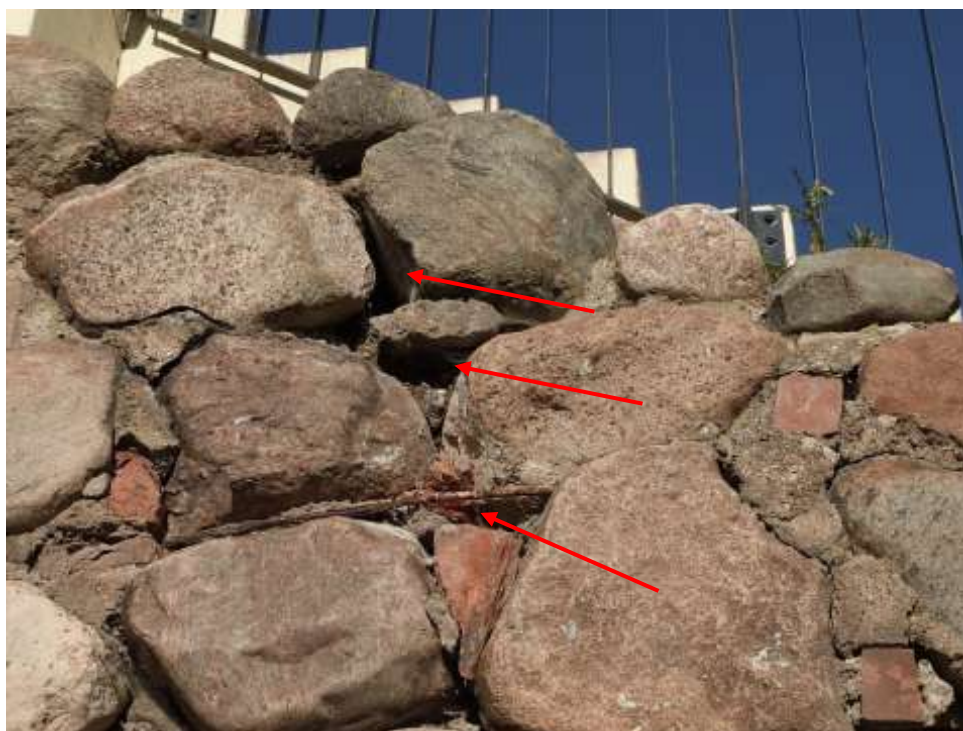
24 nuotrauka. Suiręs ir išplautas siūlių skiedinys, matosi plika surūdijusi rišančioji viela
