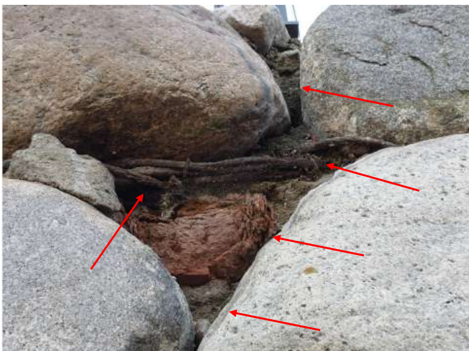
22 nuotrauka. Suiręs ir išplautas siūlių skiedinys, matosi plika surūdijusi rišančioji viela. Suirusi ir sudūlėjusi keraminė plyta
