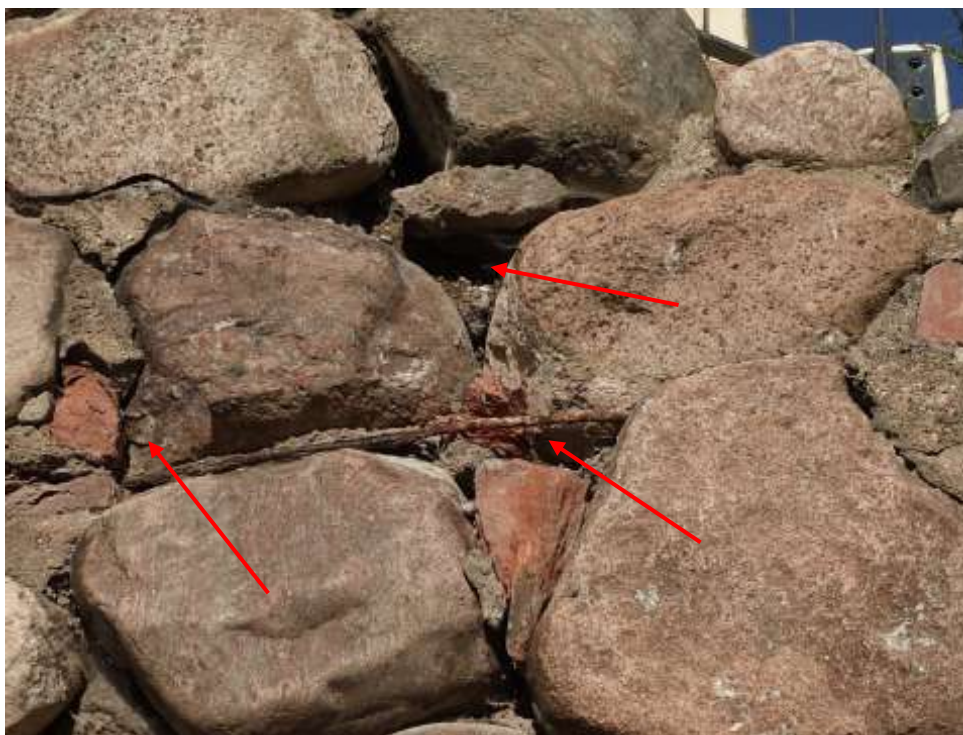
11 nuotrauka. Suiręs ir išplautas siūlių skiedinys, matosi plika surūdijusi rišančioji viela
