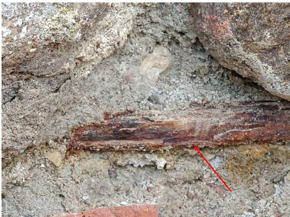
23 nuotrauka. Suiręs ir išplautas siūlių skiedinys, matosi plika surūdijusi rišančioji armatūra
