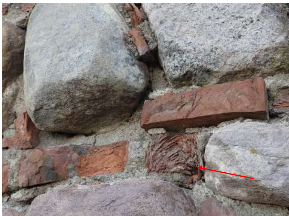
10 nuotrauka. Suiręs ir išplautas siūlių skiedinys. Suirusi ir sudūlėjusi keraminė plyta
