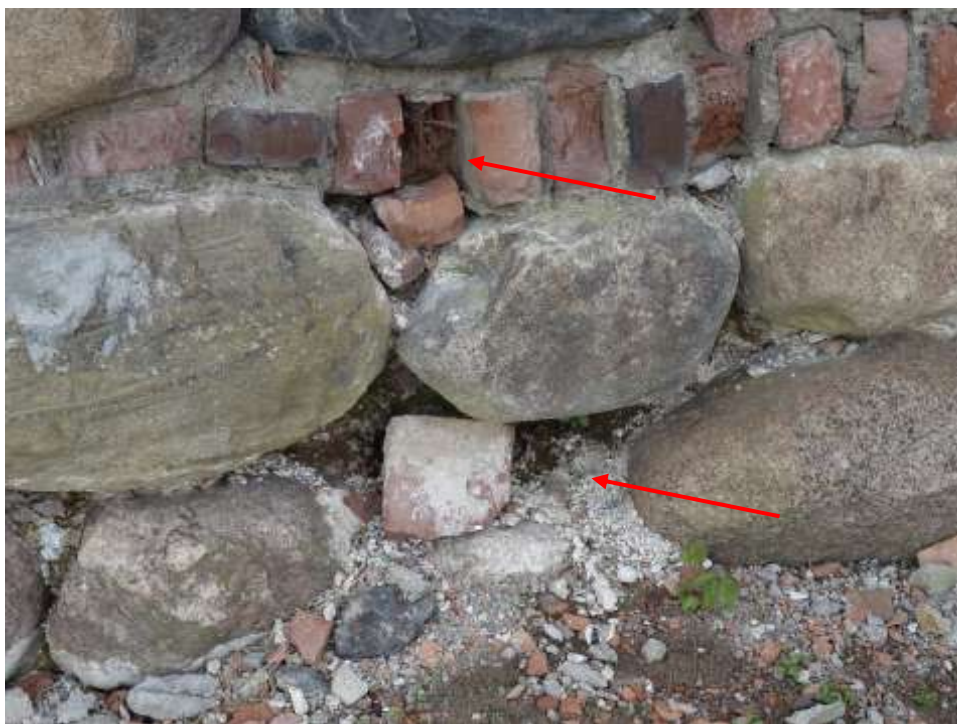
7 nuotrauka. Suiręs ir išplautas siūlių skiedinys. Suirusi ir sudūlėjusi keraminė plyta
