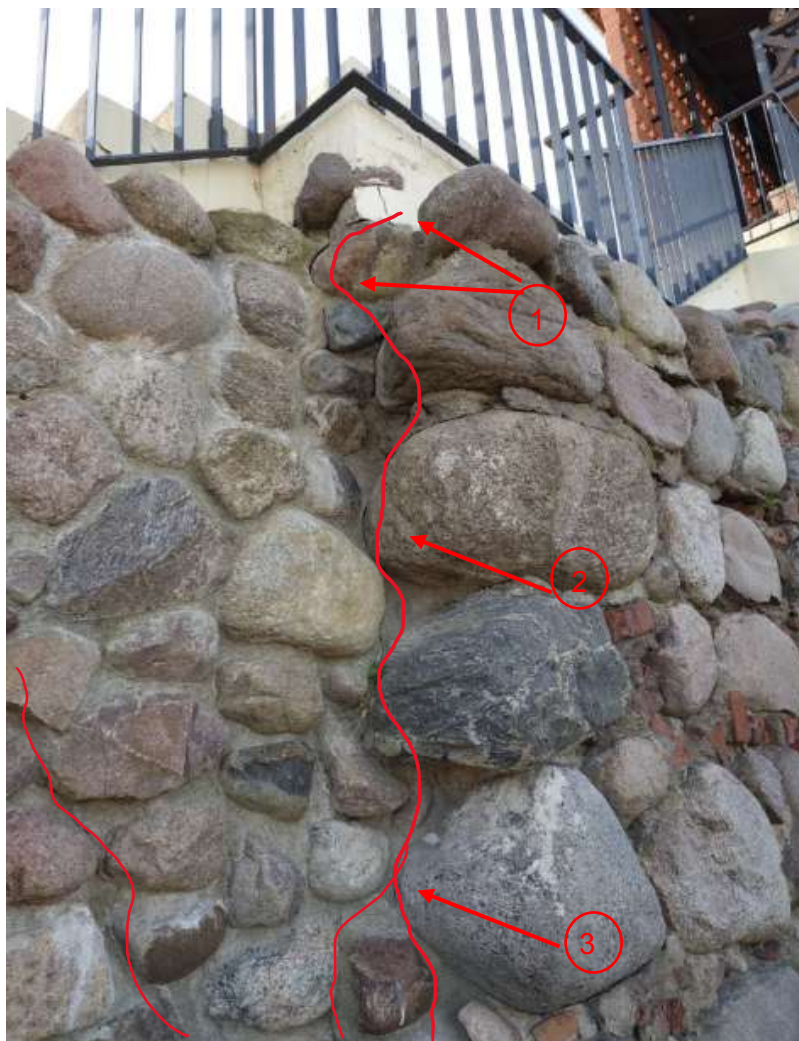
27 nuotrauka. Vakarinėje pusėje matomas ištisinis mūrijimo skiedinio įtrūkimas sienelės kampe (detaliau žiūrėti nuotraukose žemiau)
