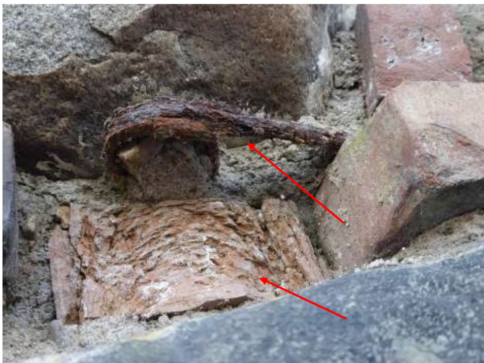
21 nuotrauka. Suiręs ir išplautas siūlių skiedinys, matosi stipriai surūdijusios rišančiosios detalės. Daugiau kaip per pusę gylio suirusi ir sudūlėjusi keraminė plyta
