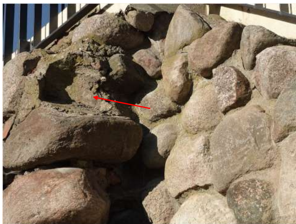
20 nuotrauka. Iškritusio akmens vieta sienos viršutinėje dalyje
