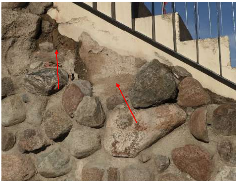
19 nuotrauka. Suiręs ir išplautas siūlių skiedinys, trūksta kelių iškritusių akmenų
