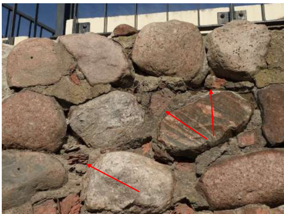
12 nuotrauka. Suiręs ir išplautas siūlių skiedinys. Suirusios ir sudūlėjusios keraminės plytos
