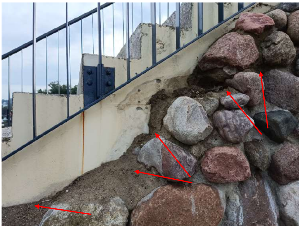
15 nuotrauka. Suiręs ir išplautas siūlių skiedinys, trūksta kelių iškritusių akmenų
