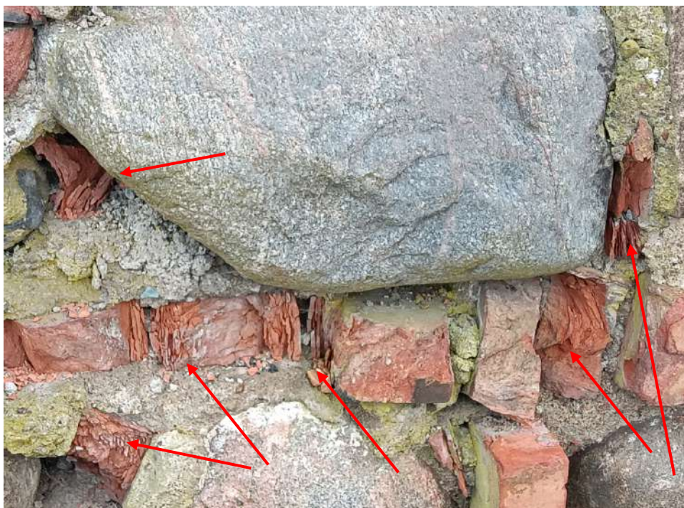
9 nuotrauka. Suiręs ir išplautas siūlių skiedinys. Visiškai suirusios ir sudūlėjusios keraminės mūro plytos
