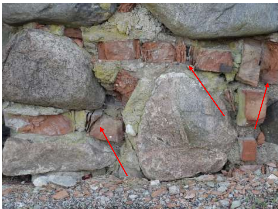
8 nuotrauka. Suiręs ir išplautas siūlių skiedinys. Suirusios ir sudūlėjusios keraminės plytos
