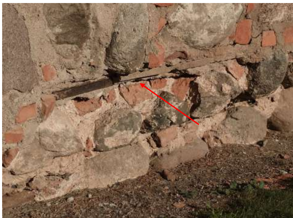
26 nuotrauka. Suiręs ir išplautas siūlių skiedinys, matosi plika surūdijusi metalinė rišančioji juosta
