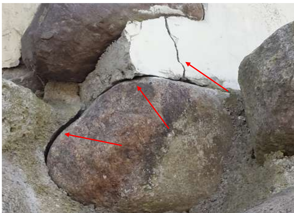
28 nuotrauka. Suiręs siūlių mūrijimo skiedinys, galimai nestabilus akmuo ardo betoninės konstrukcijos kampą (27 nuotraukoje vieta pažymėta 1)
