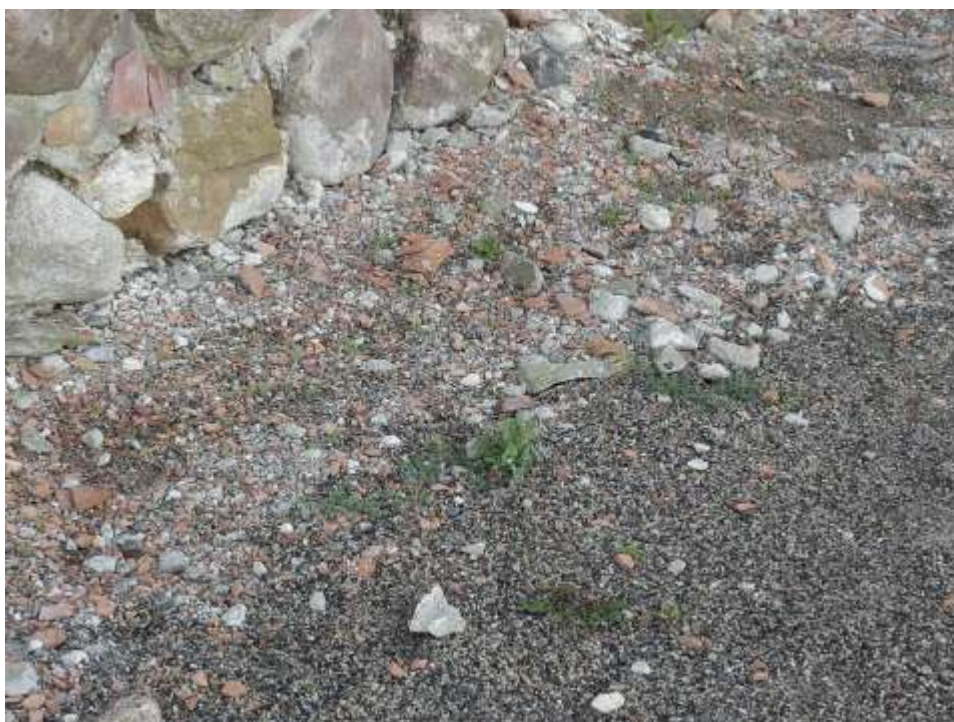
34 nuotrauka. Ištrupėję skiedinio ir keraminių plytų gabaliukai šalia tako į pilį
