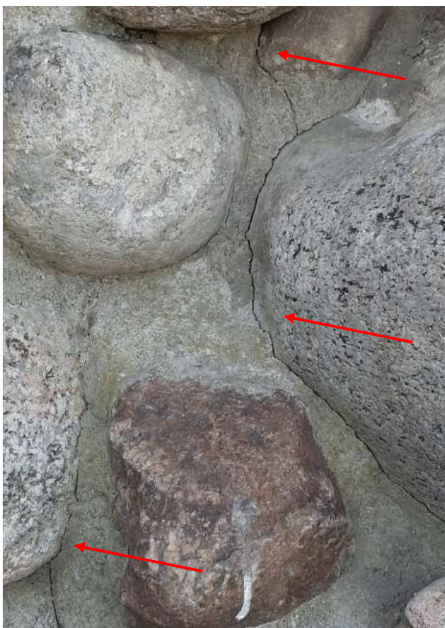
30 nuotrauka. Mūrijimo skiedinio įtrūkimas (27 nuotraukoje vieta pažymėta 3)
