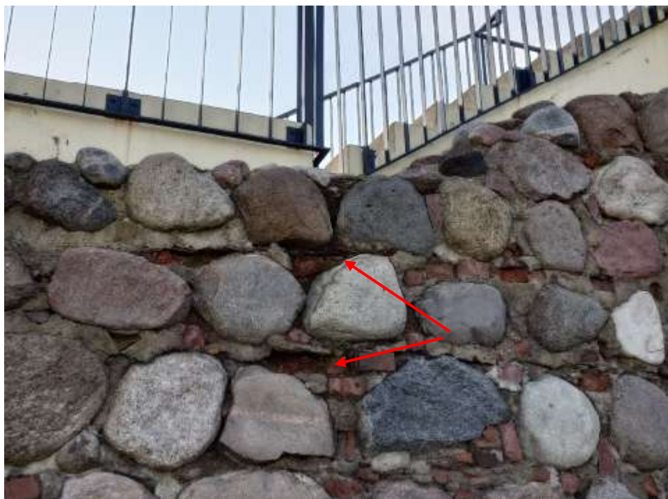
5 nuotrauka. Suiręs ir išplautas siūlių skiedinys, matosi plika surūdijusi rišančioji armatūra. Suirusios ir sudūlėjusios keraminės plytos
