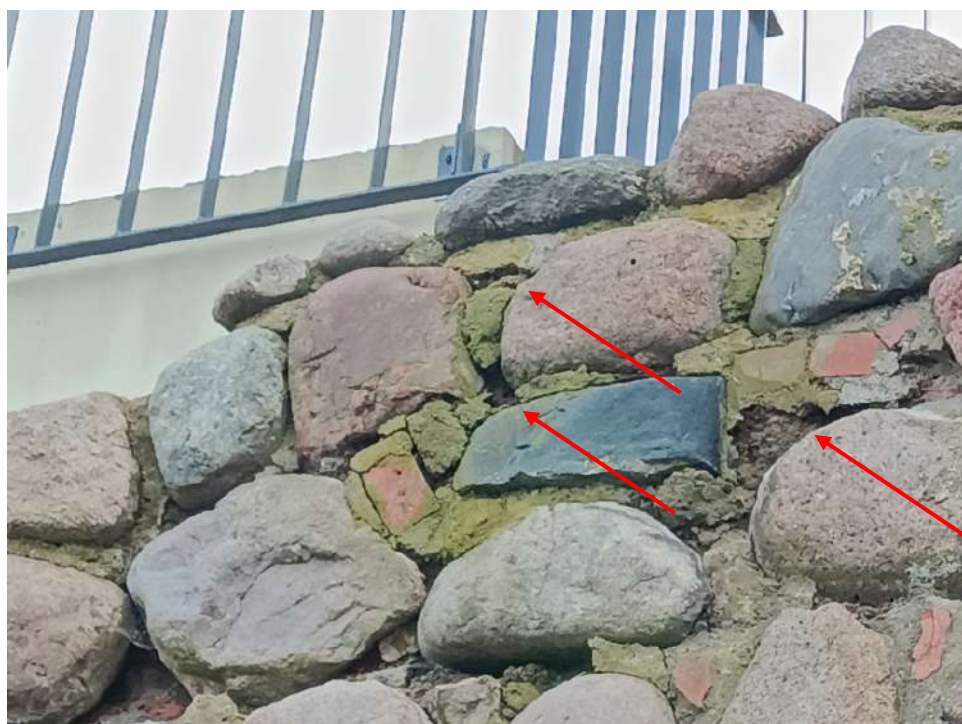
4 nuotrauka. Suiręs ir išplautas akmens-plytų mūro siūlių skiedinys
