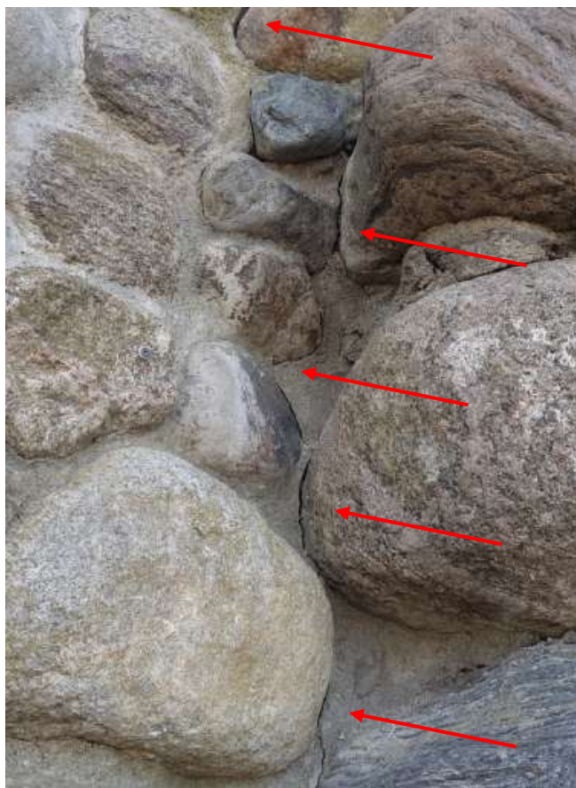
29 nuotrauka. Mūrijimo skiedinio įtrūkimas (27 nuotraukoje vieta pažymėta 2)
