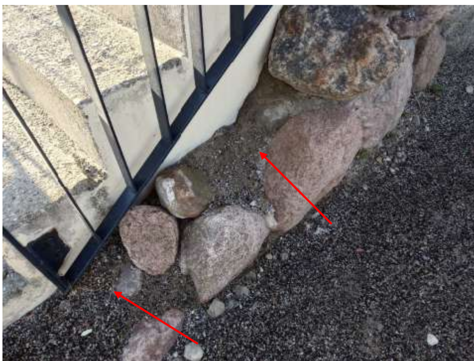
14 nuotrauka. Suiręs ir išplautas siūlių skiedinys, trūksta kelių iškritusių akmenų
