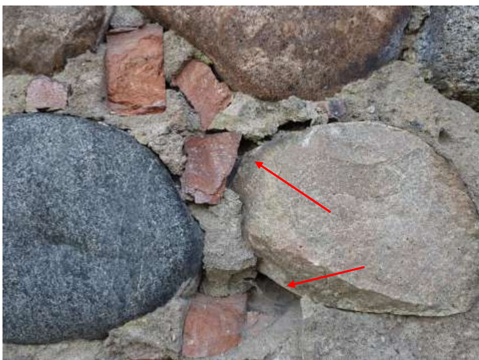
6 nuotrauka. Suiręs ir išplautas akmenų-plytų mūro siūlių skiedinys
